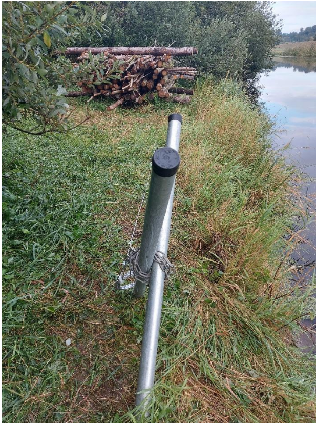
Abb. 6: Abstand der Bodenverankerung zum Floß ca. 6 m in Fließrichtung (Foto: Burkhard Fellner).
