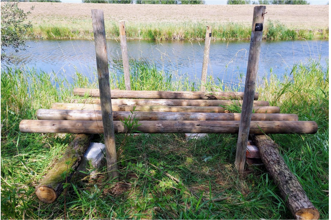
Abb. 4: Fundament des Rettungsfloßes (Foto: Burkhard Fellner).
