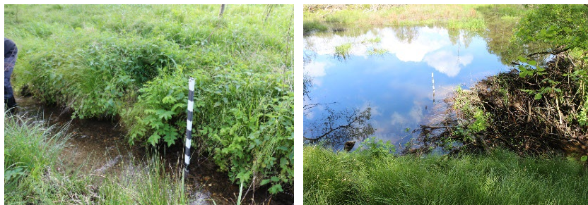
Abbildung 1: Pegelmessstellen im Zulauf (links) und im Dammbereich (rechts) am Liščí potok (Fotos: IWD)
